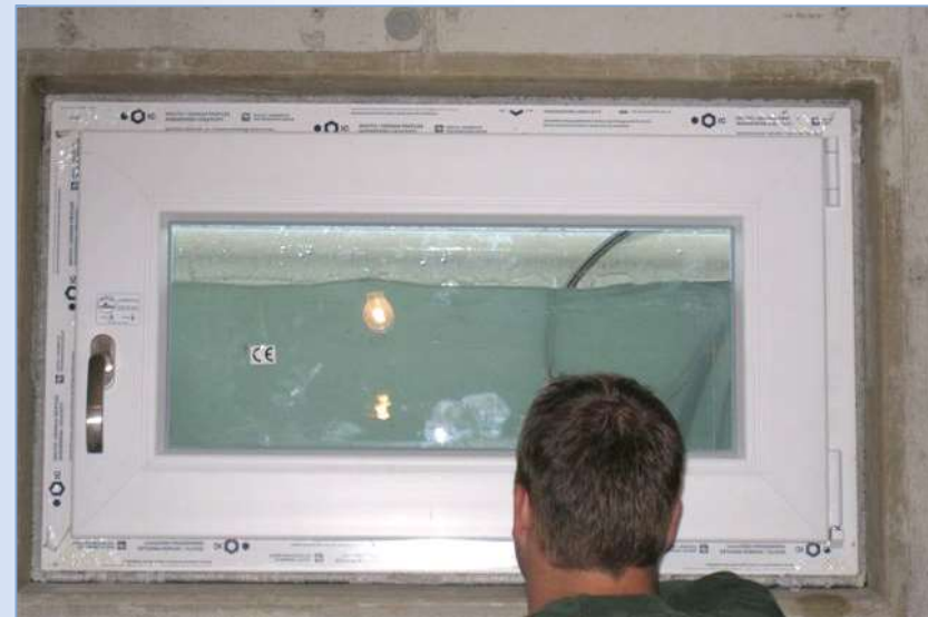
Verankertes, abgedichtetes Fenster, Bild: Broschüre Wenzler Bausysteme
