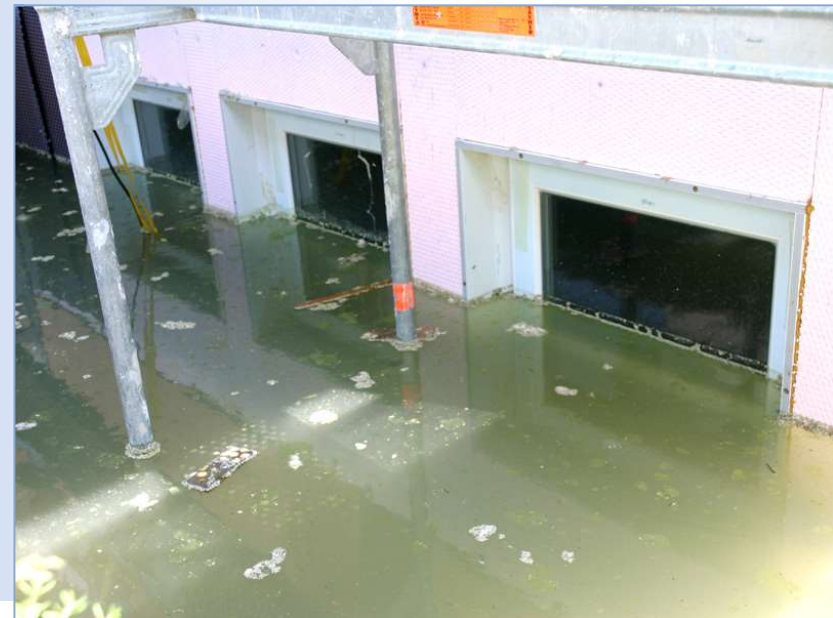
Verankertes, abgedichtetes Fenster, Bild: Broschüre Wenzler Bausysteme
