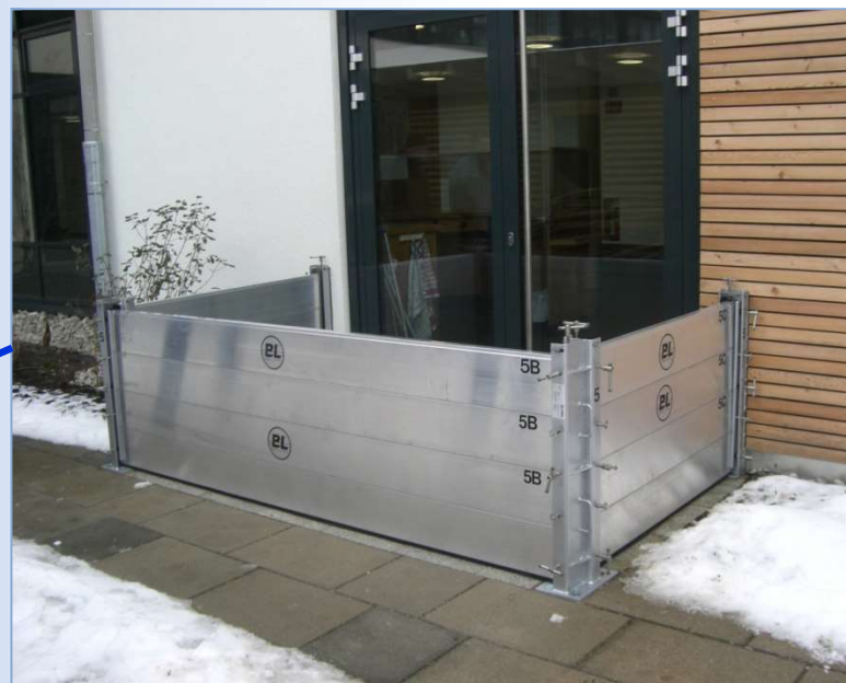
Errichtung mobiles Dammbalkenwehr
