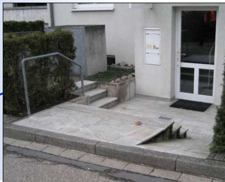
Errichtung einer dauerhaften Schwelle
