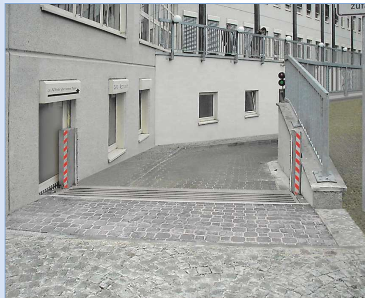
Klappschott geöffnet und geschlossen, Bild Fa. Anhamm
